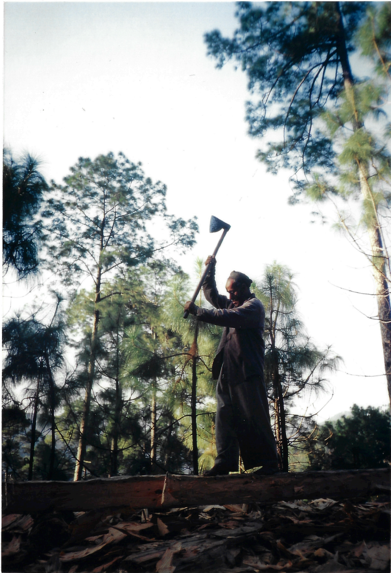
Kumaon: 13 Das Bebeilen wird mit der breiten, schweren Axt ausgeführt
