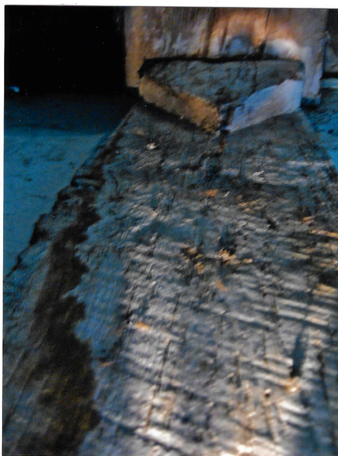
Klobsägespuren auf der Hauptsäule
