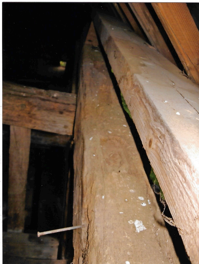
eingestemmte Löcher zur Aufnahme der Sparren
