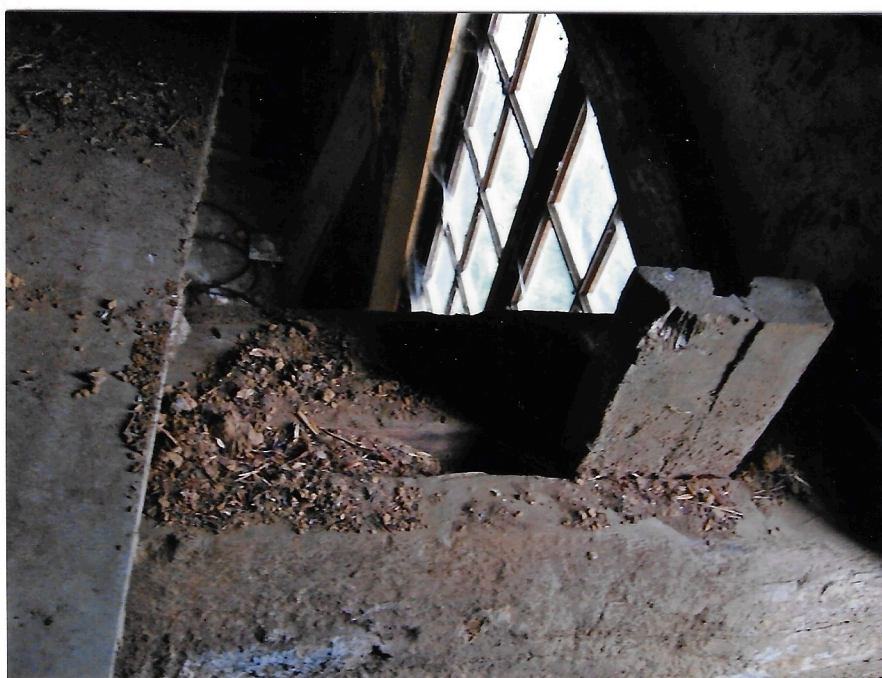
Zapfenloch im Deckenbalken zur Aufnahme der Hauptsparren
