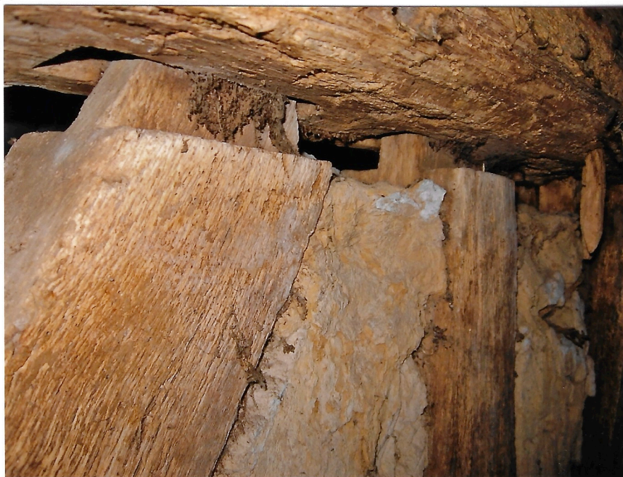
doppelseitige Zapfenbrust der Fachwerkbalken
