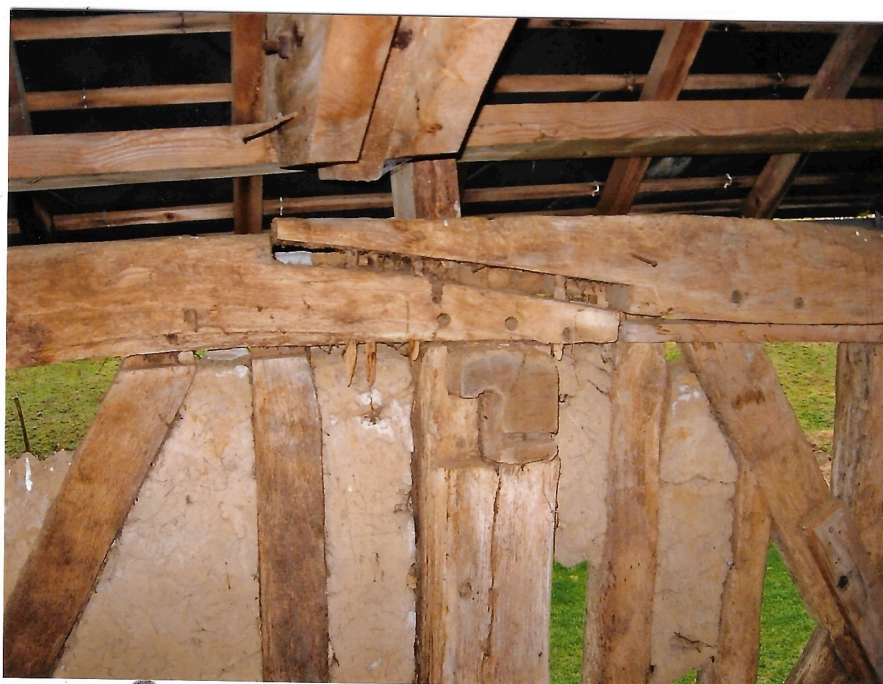
Längsverbindung des Rähms
