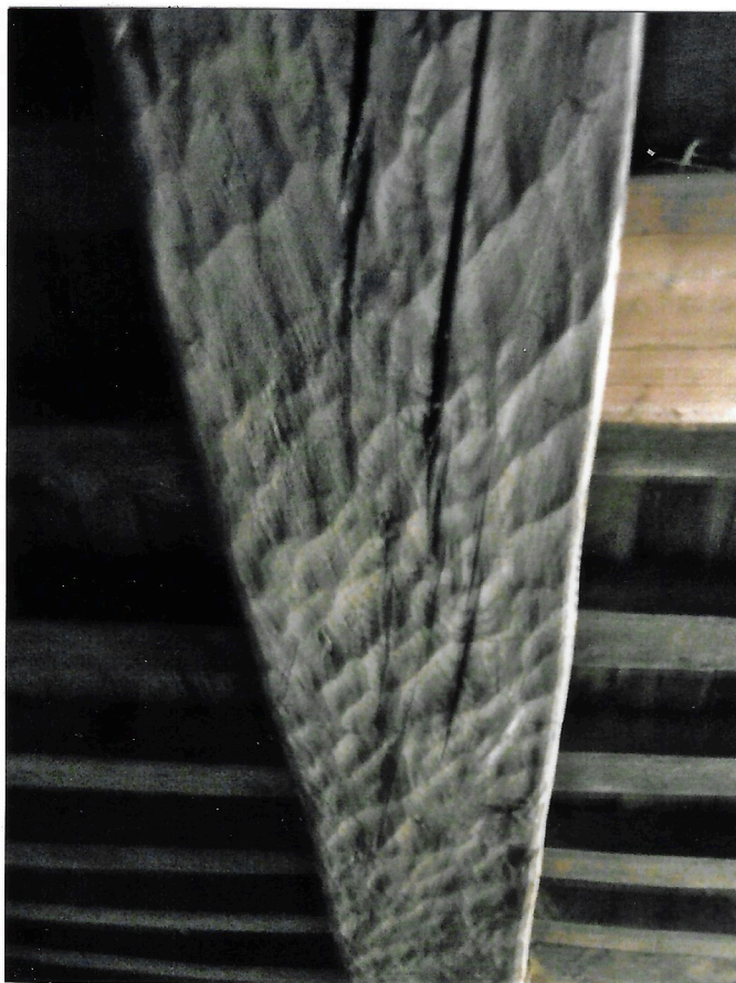
mit Dixel bearbeiteter Deckenbalken
