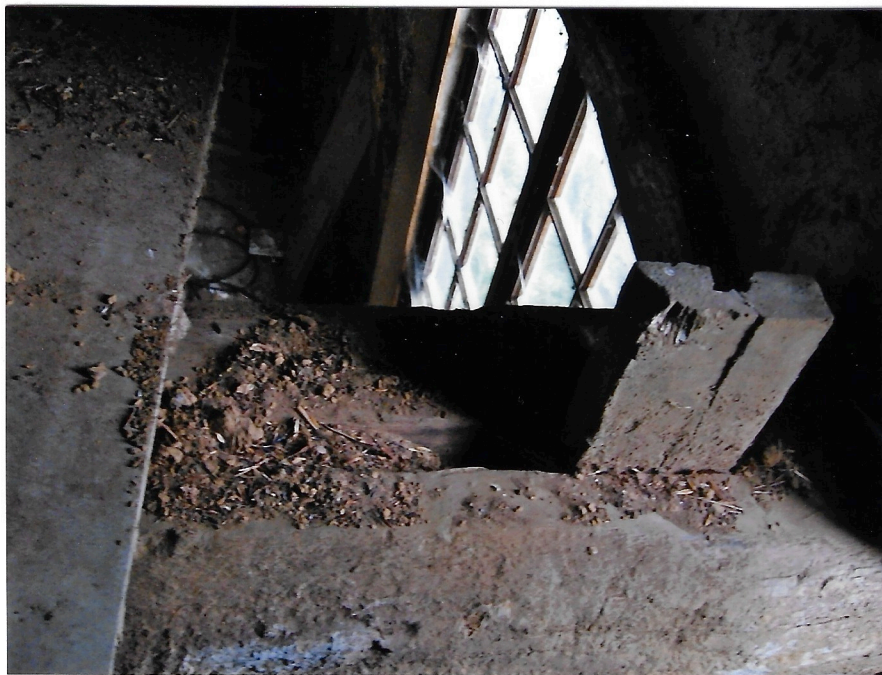
Zapfenloch im Deckenbalken zur Aufnahme der Hauptsparren
