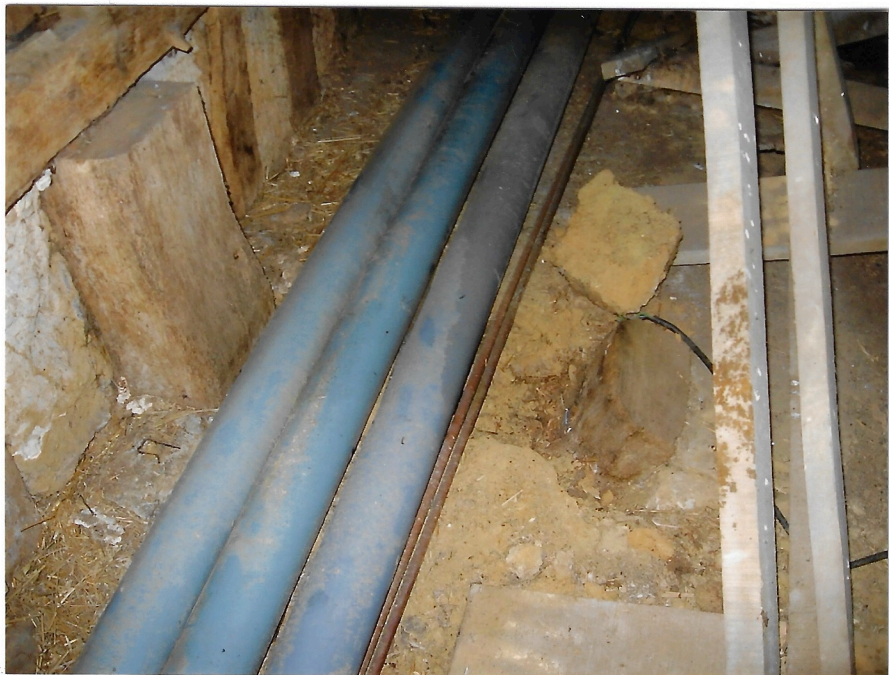
Reste der Hauptsparren im Deckenbalken des Wohnraum
