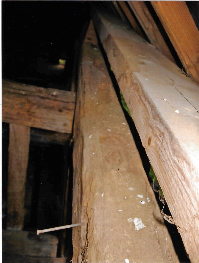
eingestemte Löcher zur Aufnahme der Sparren
