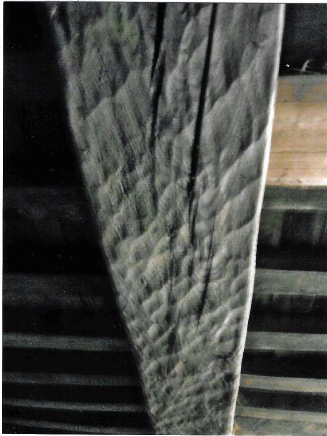
mit Dixel bearbeiteter Deckenbalken
