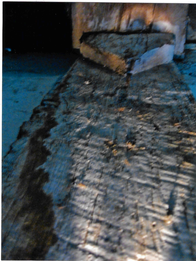
Klobsägespuren auf der Hauptsäule
