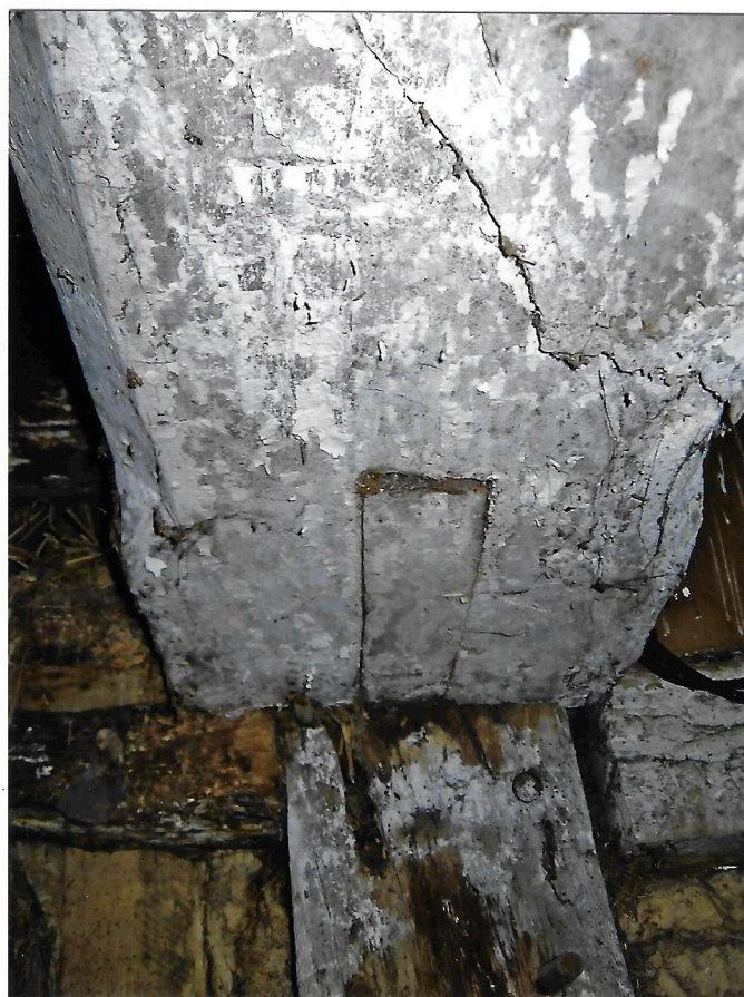
Reparatur am Deckenbalken im Stall
