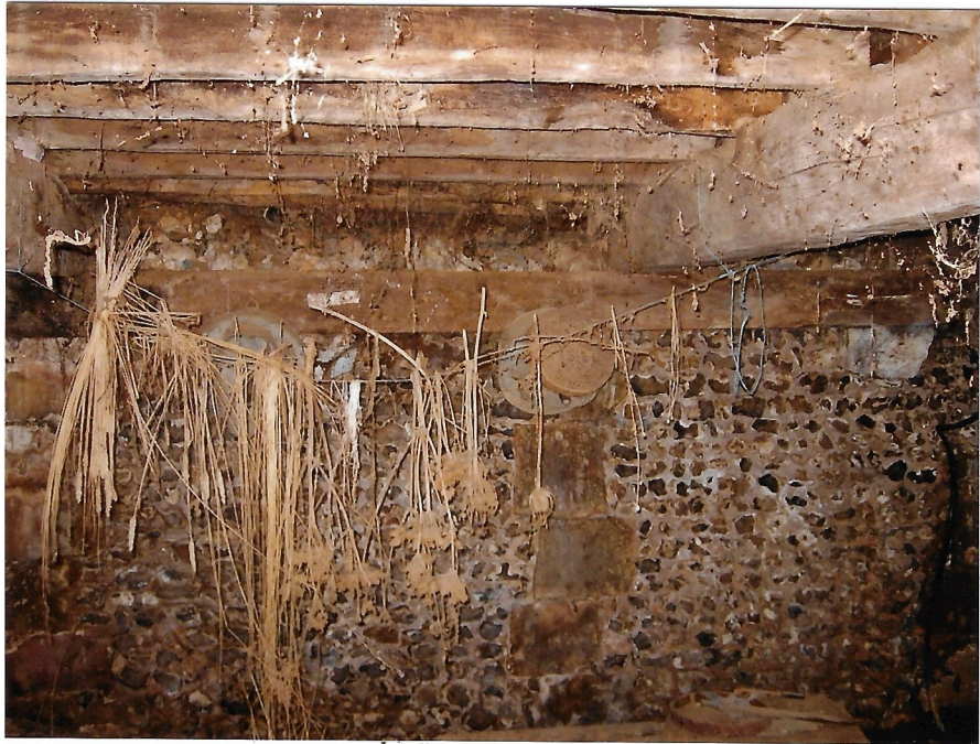
Balkenauflage im Keller
