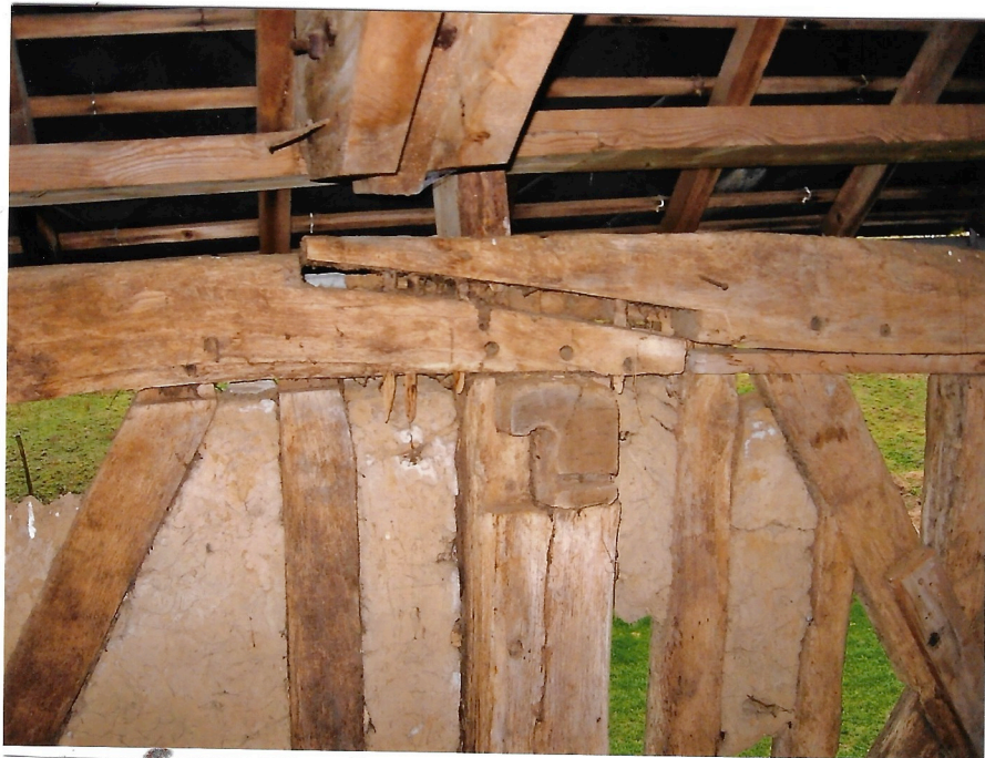
Längsverbinding des Rähms
