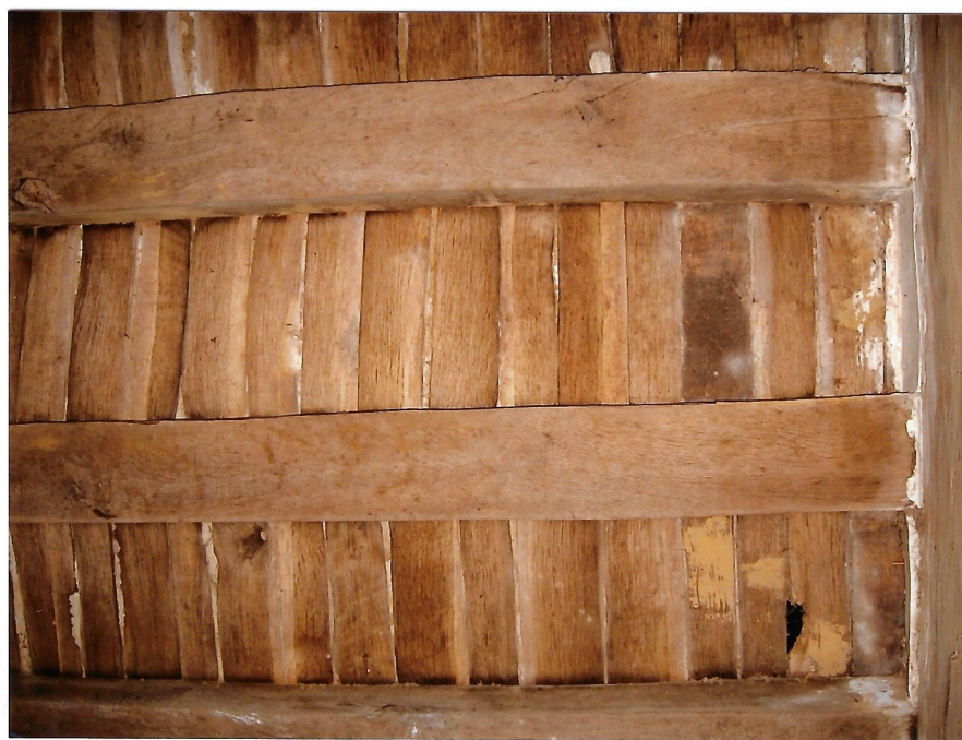
Decke im Wohnraum mit gespaltenen Eichenschindeln und Lehmboden darüber
