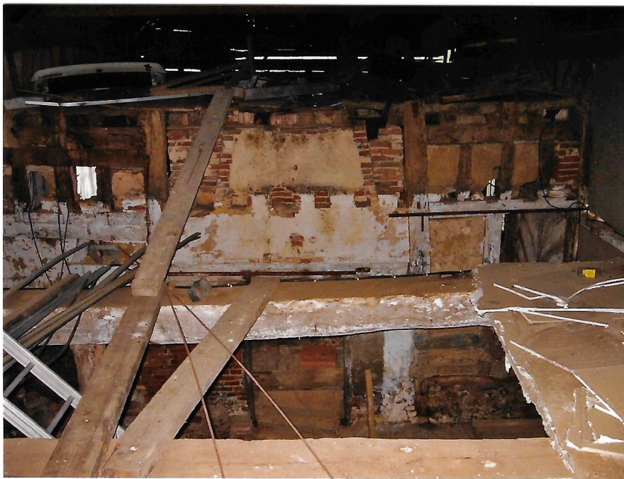
Wand zwischen Wohnraum und Stall
