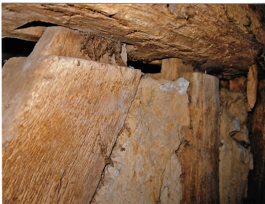
doppelseitige Zapfenbrüst der Fachwerkbalken
